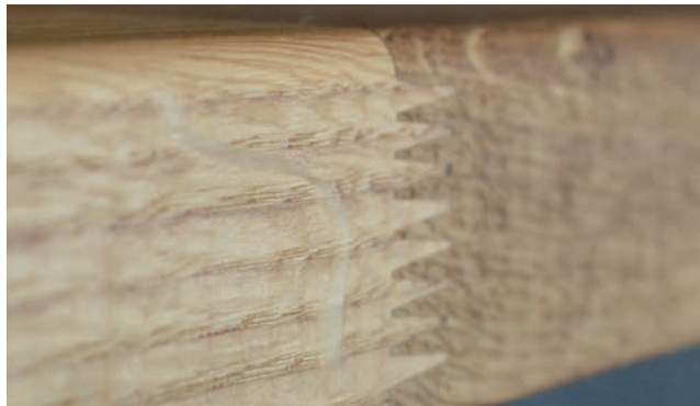
Detail keilgezinkte Platten
