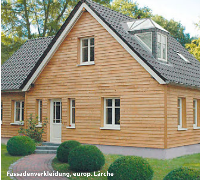
Fassadenverkleidung, Lärchenbretter
